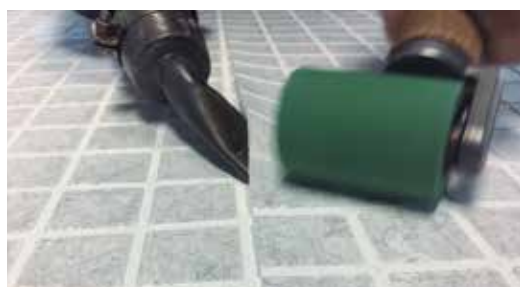
Acabado de la soldadura por solape
