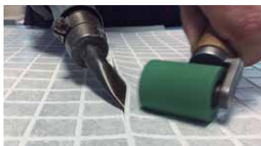
Acabado de la soldadura a testa
