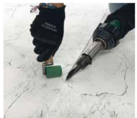
2. Schweißnaht
