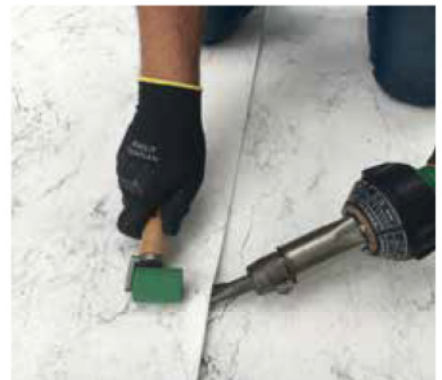
1. Schweißnaht
