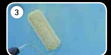
3 RENOLIT ALKORGLUE Kontaktkleber vollflächig auftragen.
