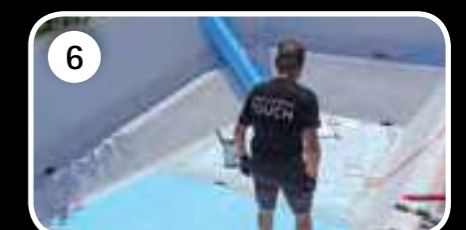
6 Boden stumpf oder überlappend verlegen.
