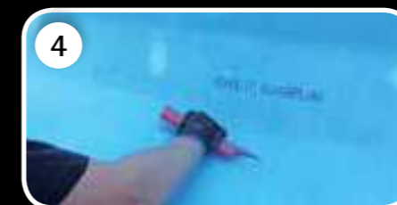
4 RENOLIT ALKORPLAN Vlies anbringen, im Fall von Osmose mit Blasen und Flüssigkeit.
