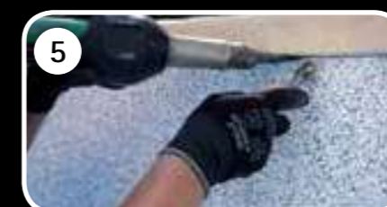
5 Wände mit RENOLIT ALKORPLAN TOUCH auskleiden.
